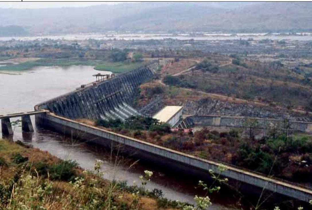
*La capacité de production de la dernière née de la famille des Inga (III) serait de 4 800 MW contre 1 424 MW pour la II et 351 MW pour la I (ci-dessus).*
