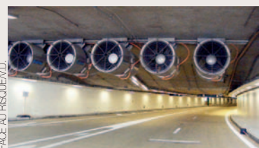
▲ Le tunnel de l'A86 (Hauts-de-Seine).
