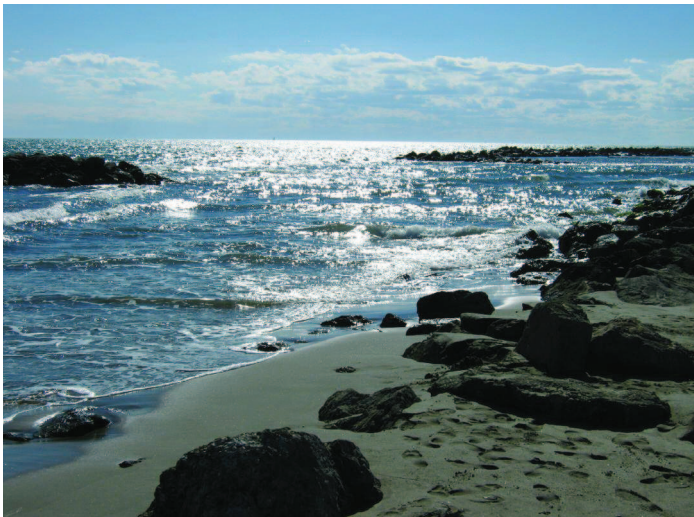
Au grand Radeau les digues sont submergées
